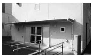
元新戸小学校跡地に建設された勝浦市福祉避難所
