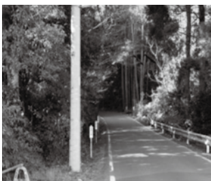
勝浦荒川線の危険箇所
