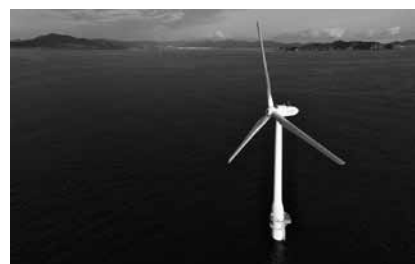
長崎県五島沖の浮体式洋上風力施設
