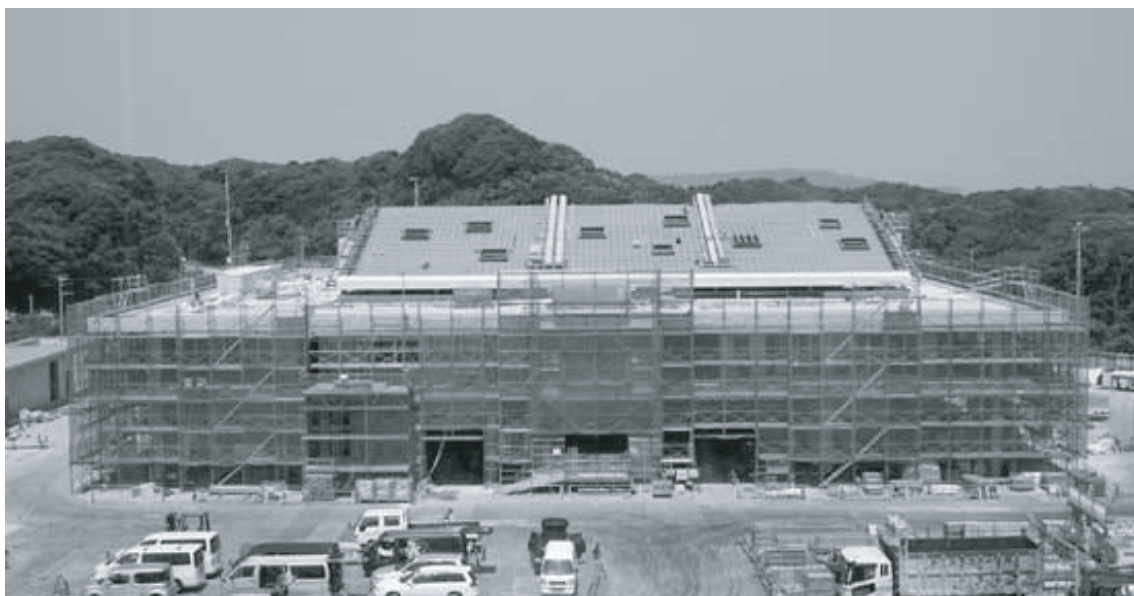
建設中の勝浦市芸術文化交流センター（平成26年7月末撮影）
