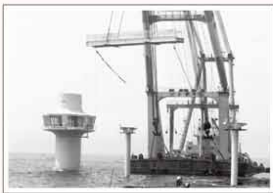
昭和55年建設中の海中公園
