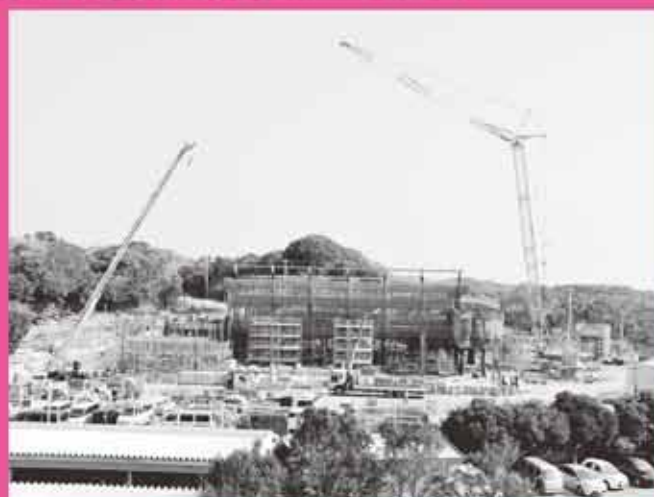
市役所4階から見た建設現場の様子
