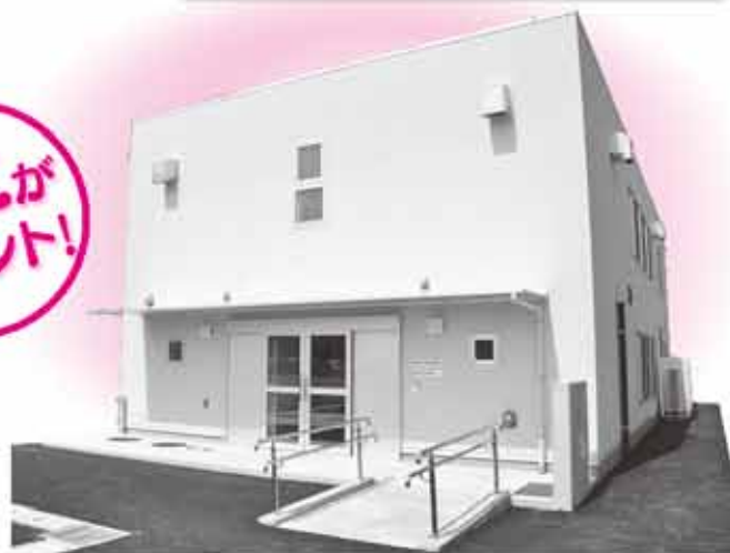
給食センターの隣に新設された、防災備蓄センター・福祉避難所
