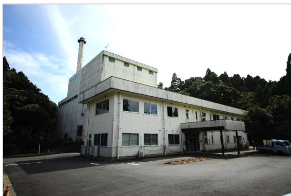
(外観：事務所、処理場)
