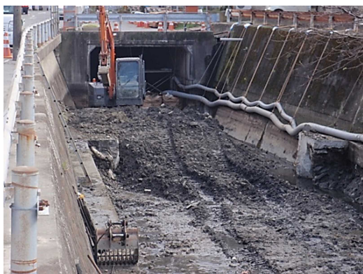
暗渠化工事の状況
