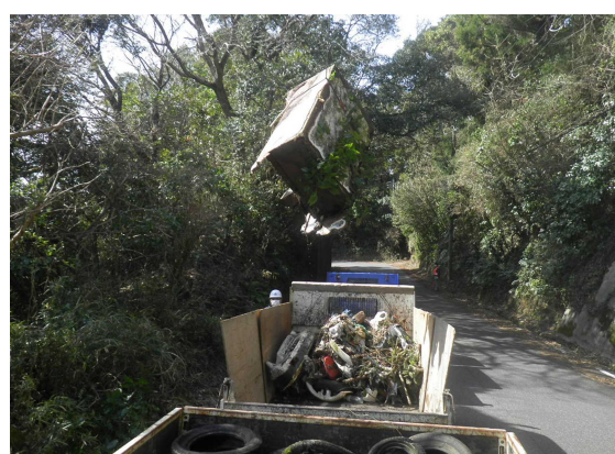
クレーン車による引き上げ作業
