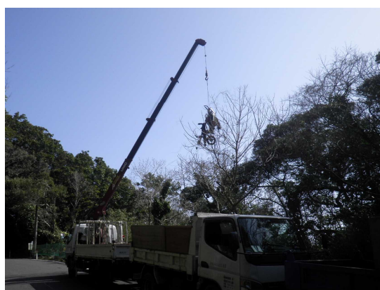
クレーン車による引き上げ作業
