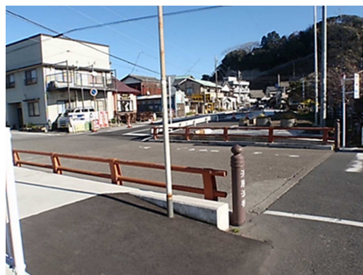
工事後の浜勝浦橋付近
