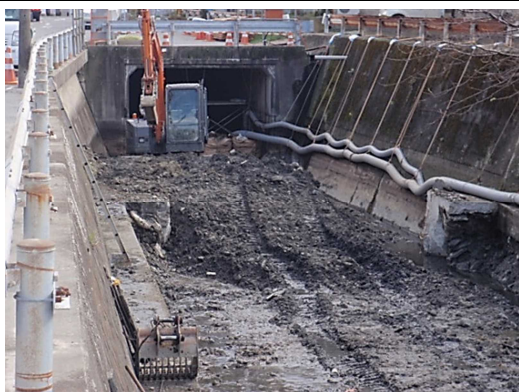
暗渠化工事の状況
