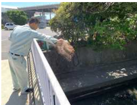
バイオ資材投入時
