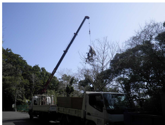
クレーン車による引き上げ作業
