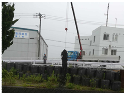
引き揚げ作業
