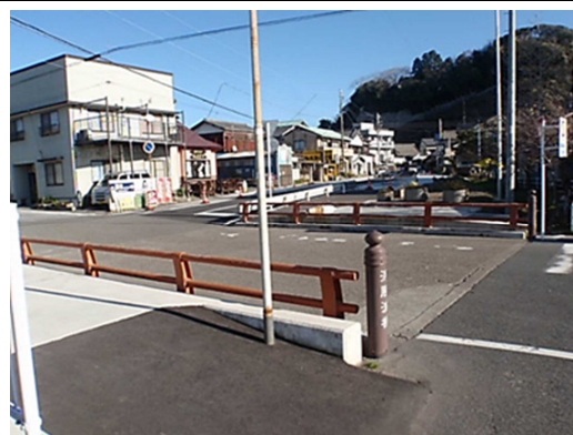
工事後の浜勝浦橋付近
