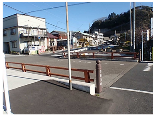
工事後の浜勝浦橋付近
