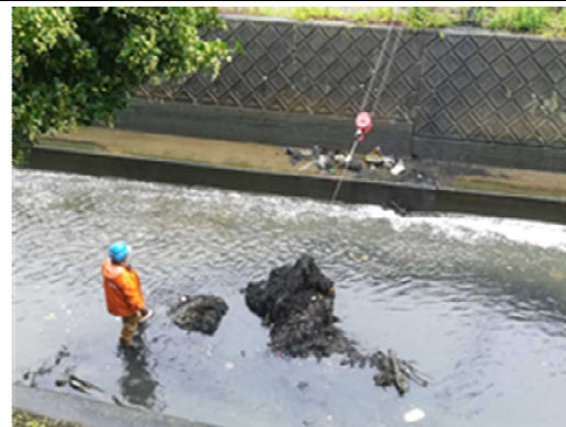
引き揚げ作業
