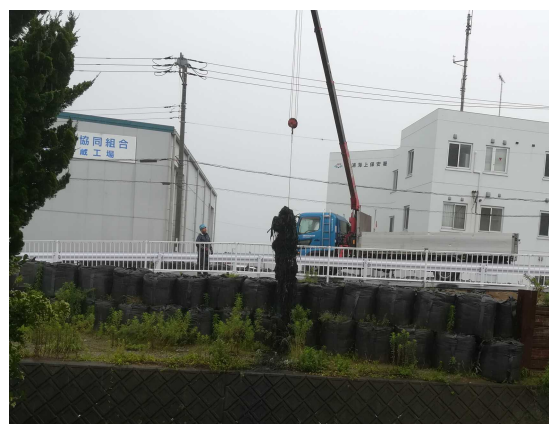
クレーン車による引き上げ作業
