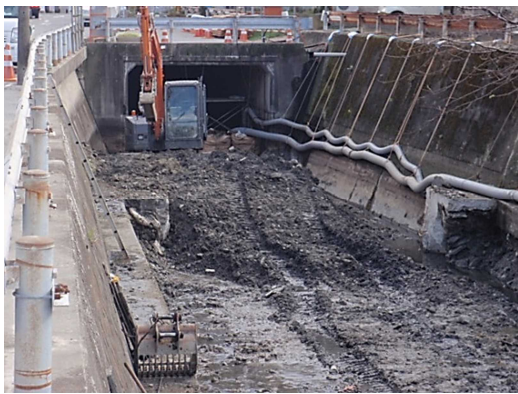
暗渠化工事の状況
