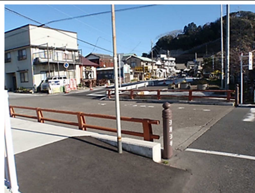
工事後の浜勝浦橋付近
