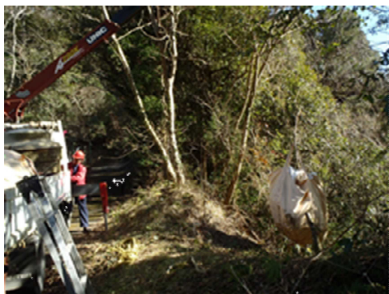
クレーン車による引き上げ作業
