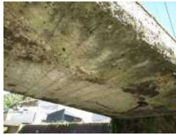
写真4.1 損傷が著しく、隣接した橋梁へ交通の切り替えが可能な例
