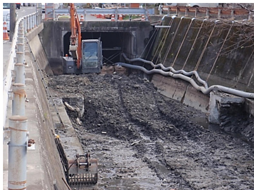
暗渠化工事の状況
