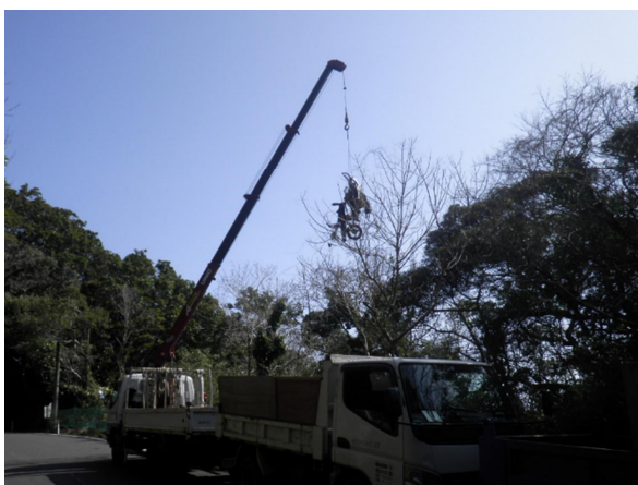
クレーン車による引き上げ作業
