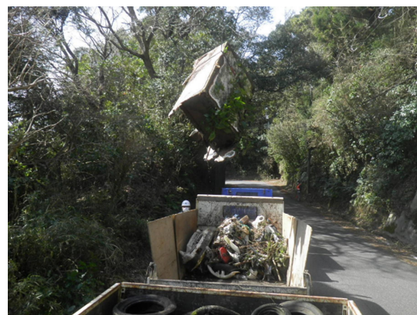
クレーン車による引き上げ作業
