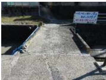
写真4.1 損傷が著しく、隣接した橋梁へ交通の切り替えが可能な例
