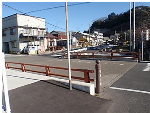
工事後の浜勝浦橋付近
