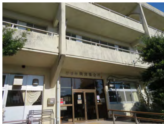
空き公共施設の利活用
