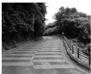
市役所入口道路
